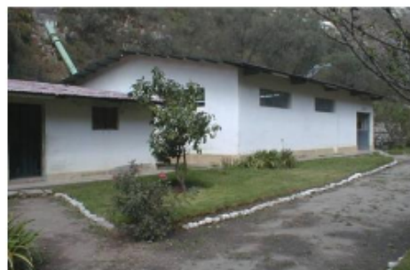
Casa de máquinas
