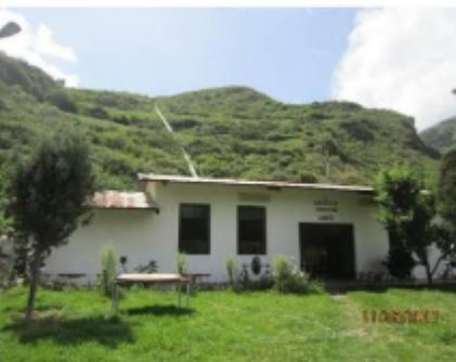
Casa de máquinas
