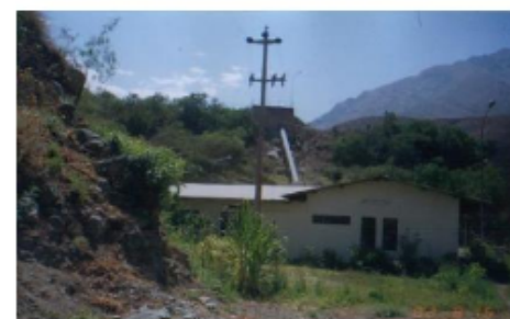
Tubería de presión y casa de máquinas
