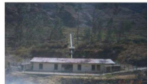
Casa de máquinas
